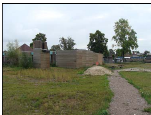
Foto 2 Plangebied met elektriciteitshuisje
