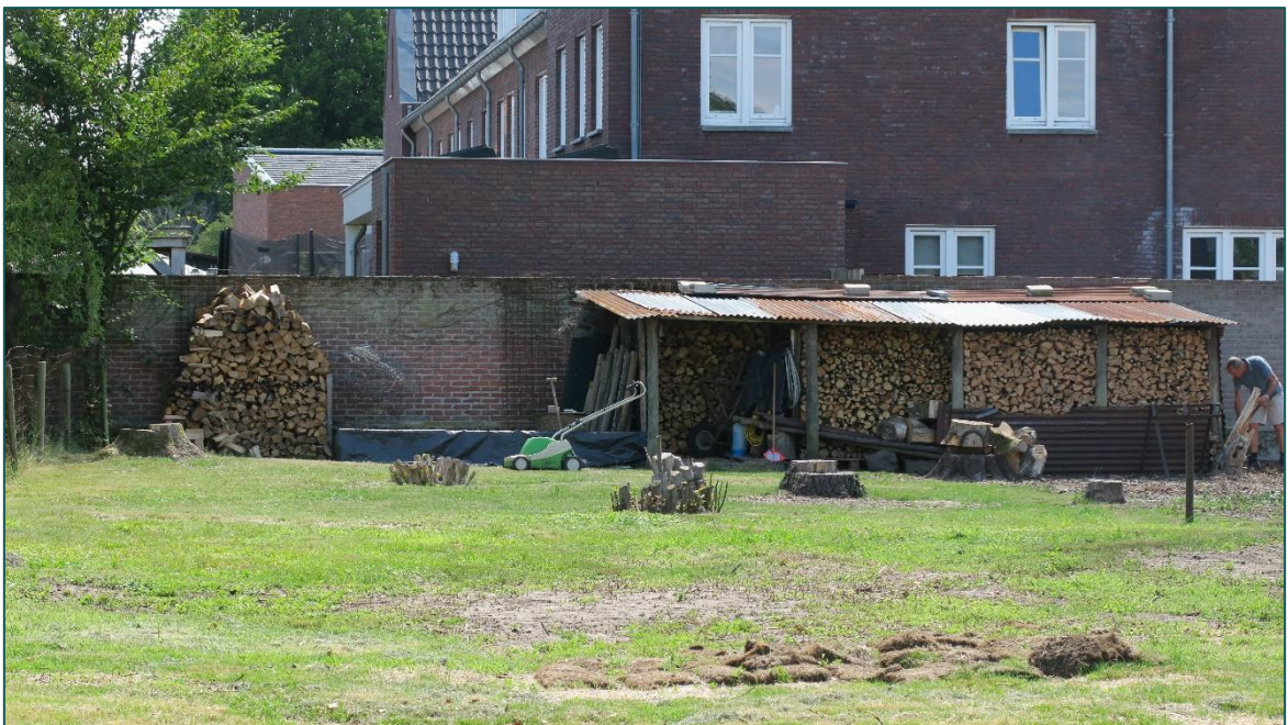
Figuur 2 De kleine overkapping voor houtopslag aan de zuidzijde van de planlocatie wordt verwijderd.
