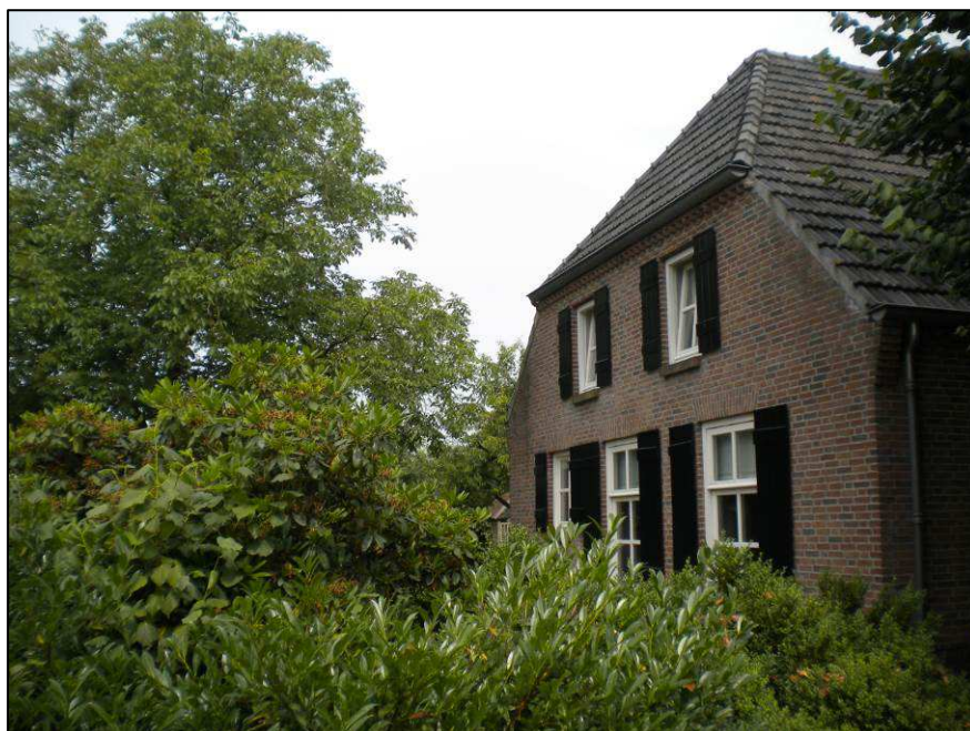
Figuur 5: Langgevelboerderij aan Schaijksedreef 7
