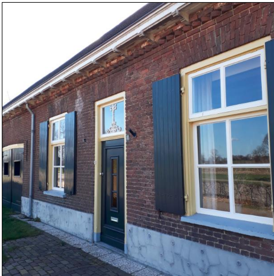
Figuur 2: De noordgevel van de historische bebouwing (gevel parallel aan de Hoog Beugt) in het plangebied (maart 2018).
