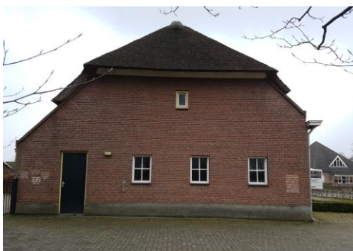
Figuur 15 De eindgevel met nieuwe stenen. Links en rechts voegmonsters
