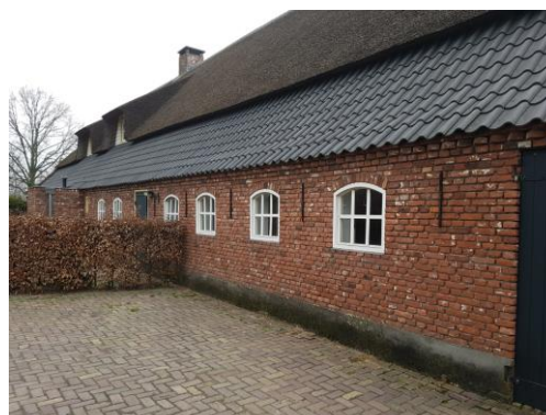
Figuur 14 De geheel nieuwe achtergevel met hergebruikte stenen.
