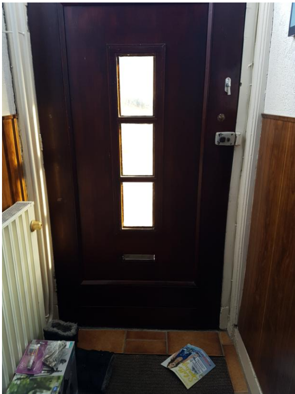
Figuur 18 Halletje achter de verplaatste en vernieuwde voordeur.
