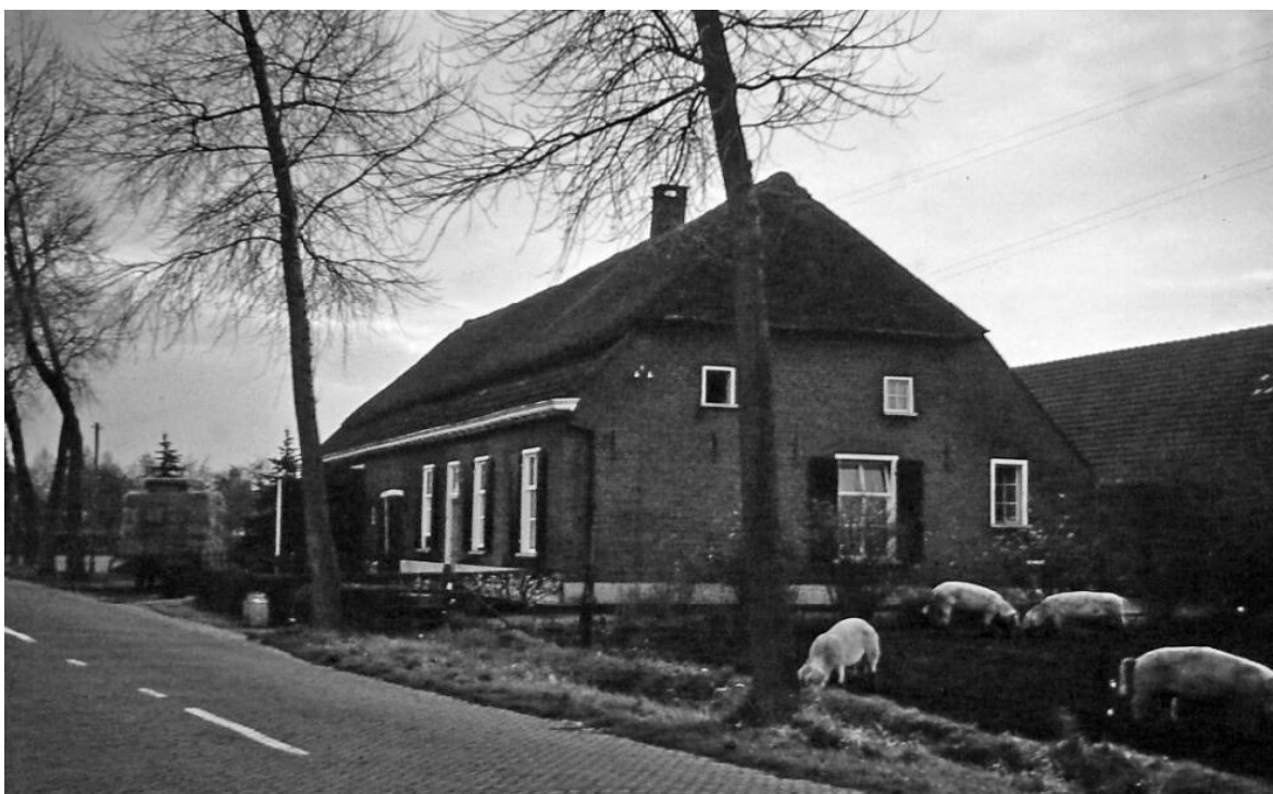
Figuur 2 Voorgevel en kopgevel in de jaren zestig
