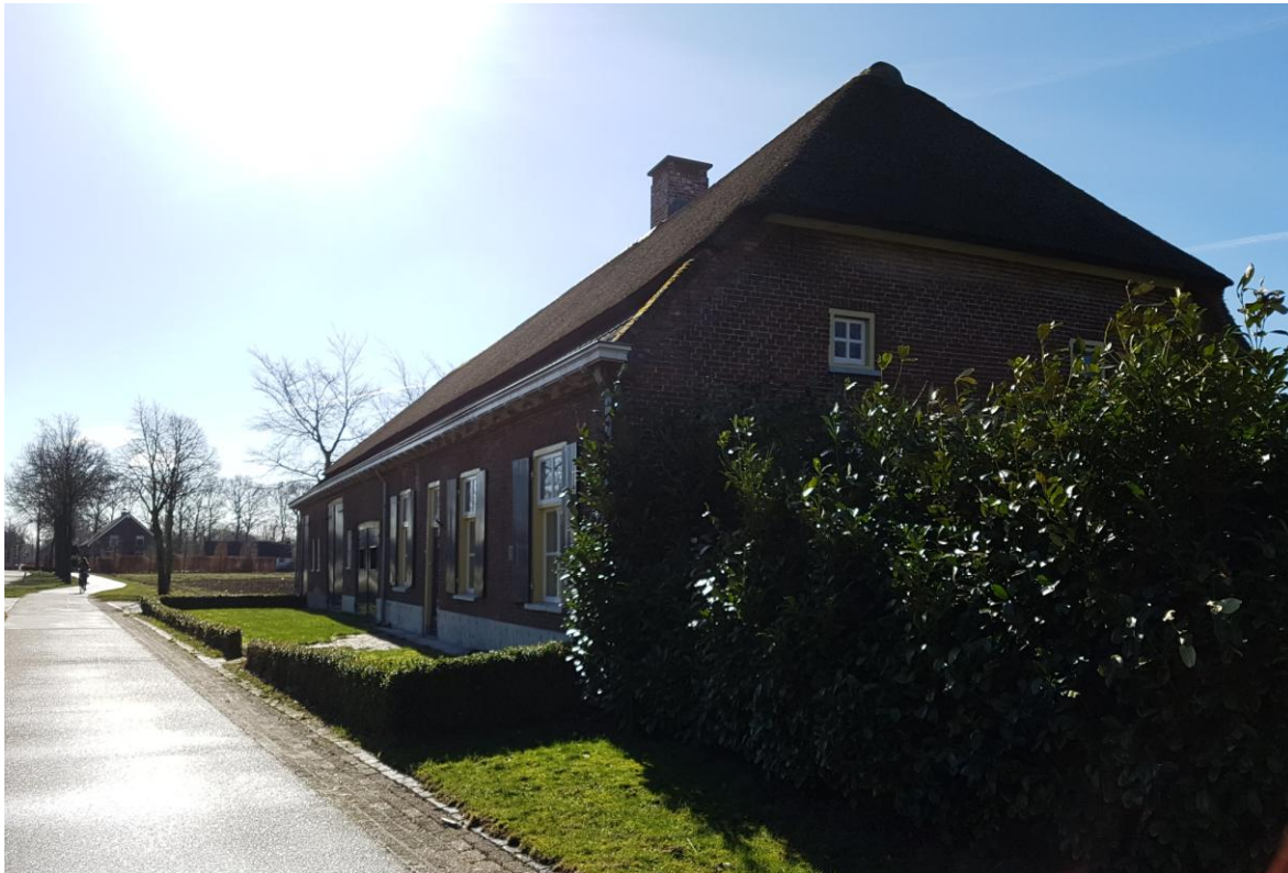
Figuur 1 Voorgevel en kopgevel van de boerderij
