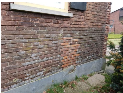
Figuur 13 Het oude voegwerk is uitgeslepen voor nieuw voegwerk. Onder het bouwspoor van het verdwenen kelderraam.
