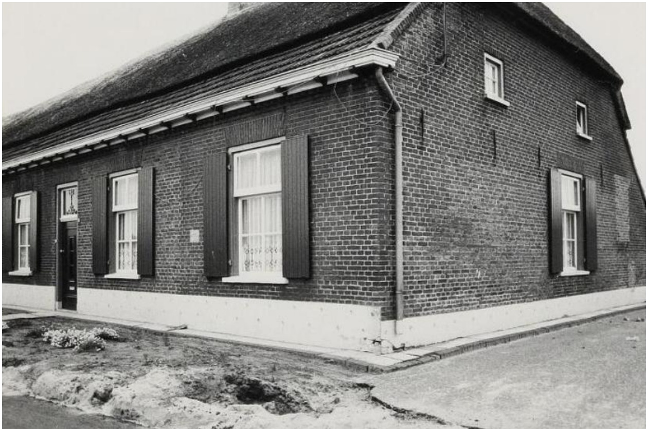
Figuur 6 De voordeur is verplaatst. Het spoor van de oude situatie is nog zichtbaar met rechts de gevelsteen. In de kopgevel is nog geen tweede raam. Rechts de bouwsporen van het voormalige kelderraam en opkamerraam.
