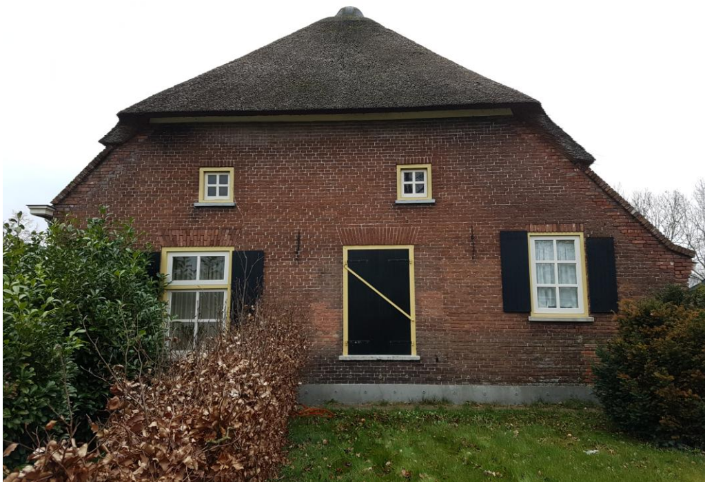
Figuur 12 In de kopgevel is links het later aangebrachte raam. Bij het slaapkamerraam zijn de luiken gesloten door middel van een sluitijzer en sluitpen, die aan de binnenzijde met een spie of pin is vergrendeld. Het opkamerraam rechts is weer teruggebracht.
