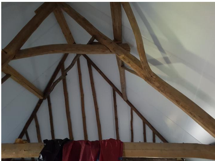
Figuur 24 Het wolfseinde van de eindgevel heeft nog de originele daksporen
