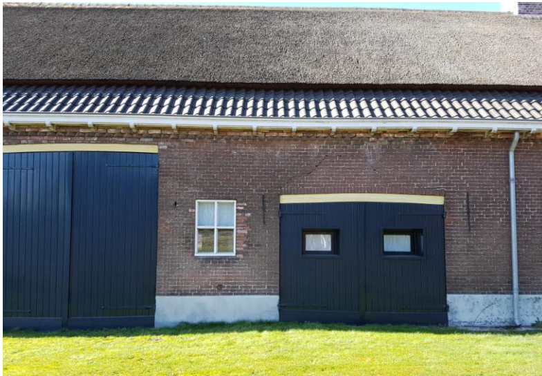
Figuur 10 De betonnen ramen in stal en schuur zijn later aangebracht. De deuren hebben hun originele hangwerk.
