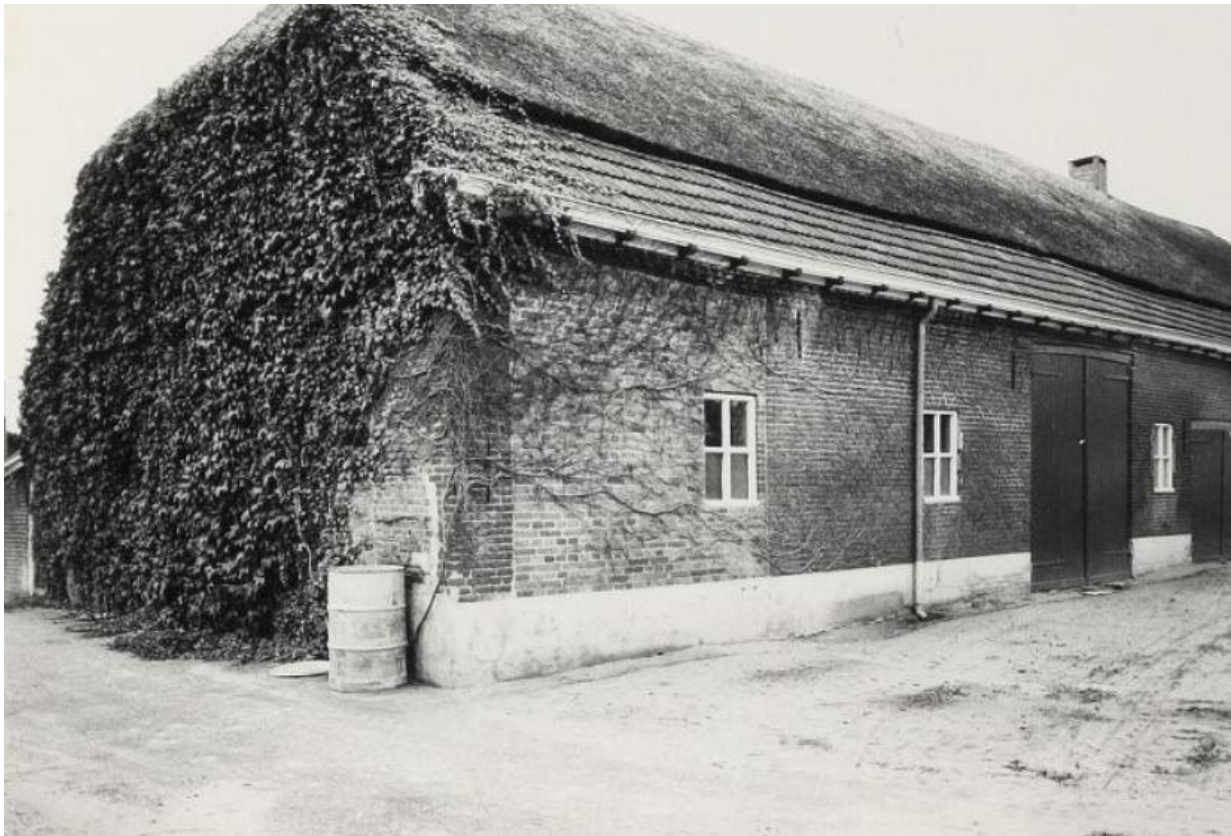
Oude foto van de afgebroken eindgevel, wat vroeger de oorspronkelijke voorgevel van het hallehuis was.
