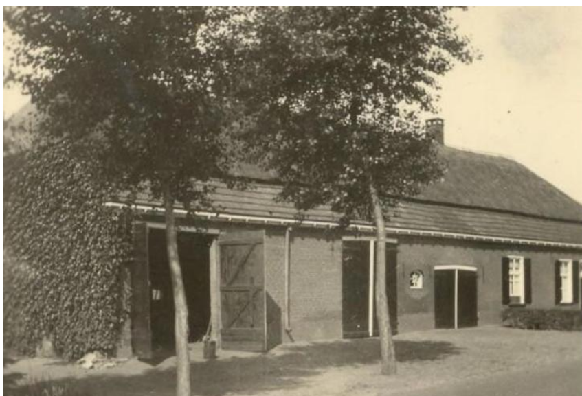
Figuur 5 Hier heeft de boerderij slechts één raampje in de stal. De lage dubbele deur is de mestdeur van de potstal. Achter de volgende hoge deuren is de deel waarop oorspronkelijk met de dorsvlegel werd gedorst. De achterste hoge deuren waren voor de berging van karren maar ook voor inrijden om koren te lossen.
