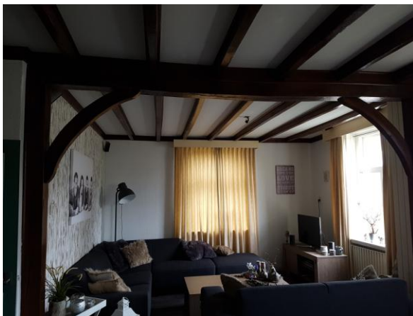
Figuur 7 De voorkamer is bij de herd gevoegd tot een grote kamer. Op de plaats van de tussenmuur heeft men een rustieke draagconstructie gemaakt.
