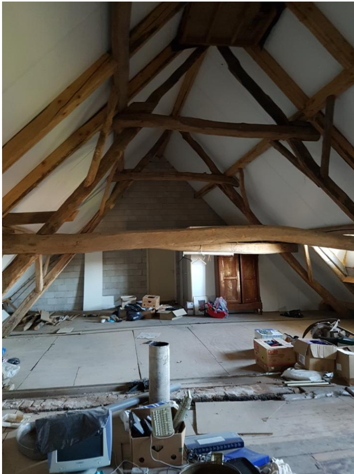
Figuur 21 De zolder met A-spanten. Achter de pijp is het restant van de oude brandgevel
