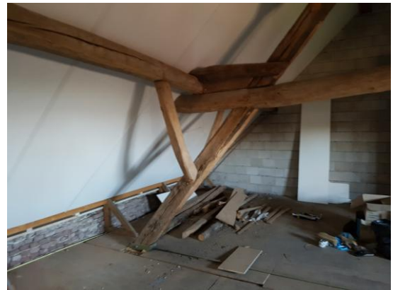
Figuur 23 Om de gording op zijn plaats te houden is een extra ondersteuning aangebracht
