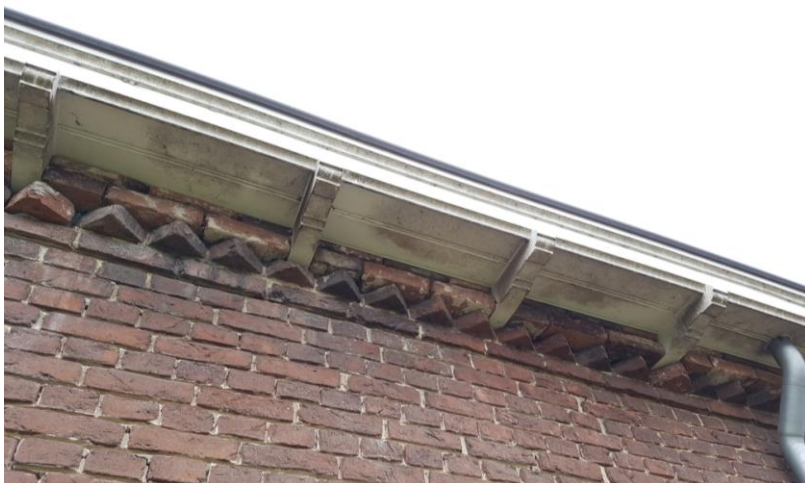
Figuur 11 De voorgevel heeft een fraaie handvormsteen. Gevelrand met muizentand. Bakgoot op sierlijke klossen
