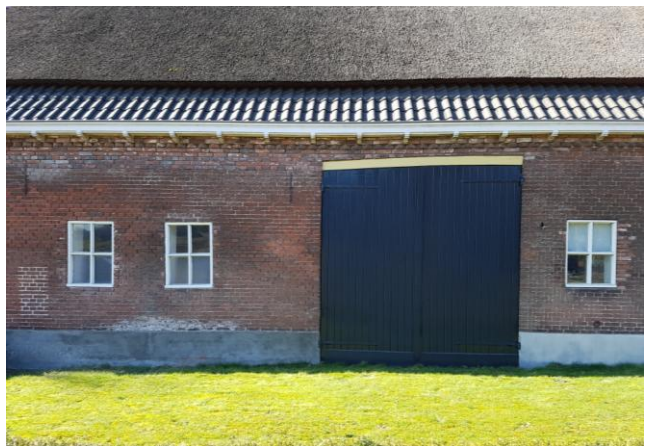
Figuur 8 Na de specialisatie in de bedrijfsvoering werd ook het schuurgedeelte veestalling. Overal kwamen stalramen in de gevel.
