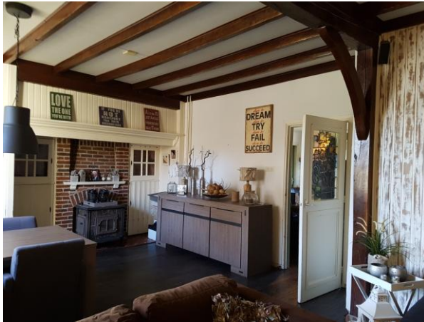
Figuur 16 Van de oorspronkelijke schouw is de schouwbank met bordenrand nog bewaard gebleven.
