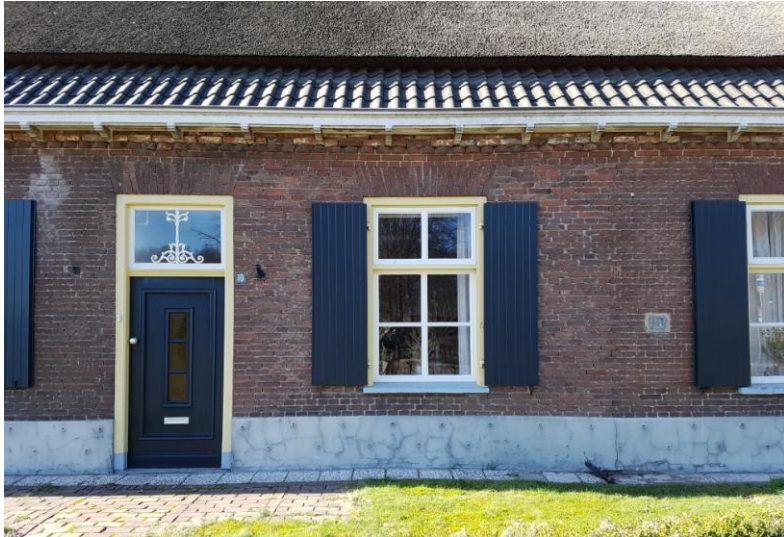
Figuur 9 Het woongedeelte met de verplaatste voordeur. Alleen het raam uiterst rechts zit op de oorspronkelijke plaats.
