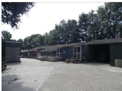
Figuur 5 Te slopen bebouwing
