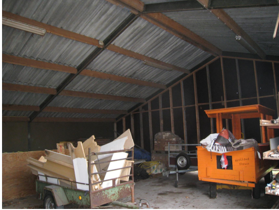
Figuur 11 binnenkant schuur, dit is geen potentiële vleermuisverblijfplaats.
