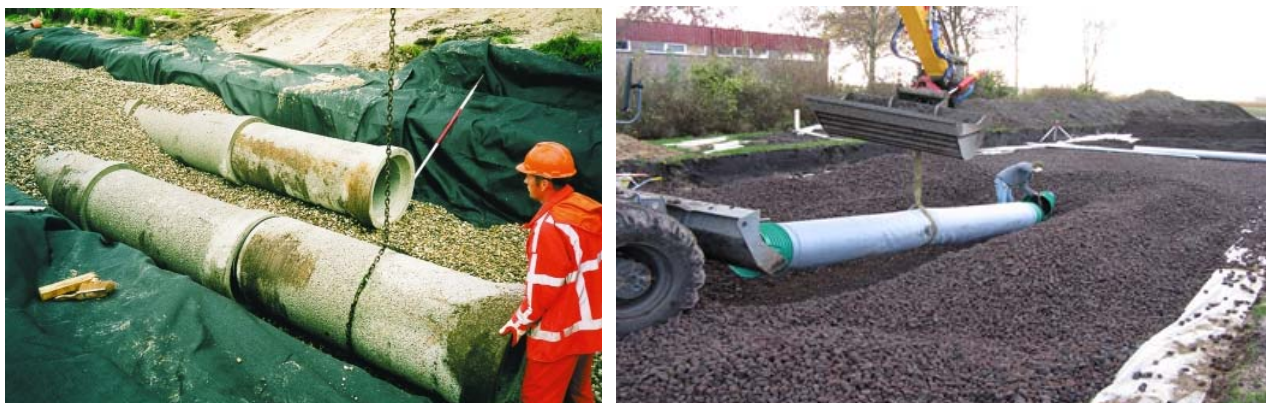
Afbeeldingen 4.5 en 4.6: Aanleg van een infiltratieriool
