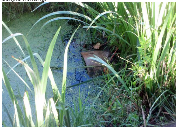
Foto 5. Deel van de watergang aan de Schaapsdijk, met duiker onder de dam.
