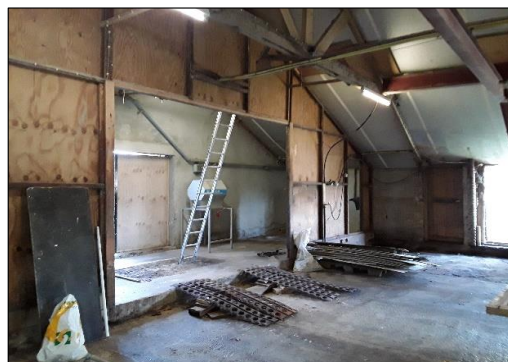
Binnenzijde opstal 1 (M05) Asbesthoudend
