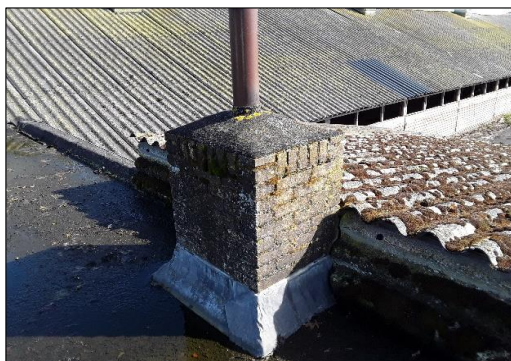
Bitumen schoorsteen Niet asbestverdacht
