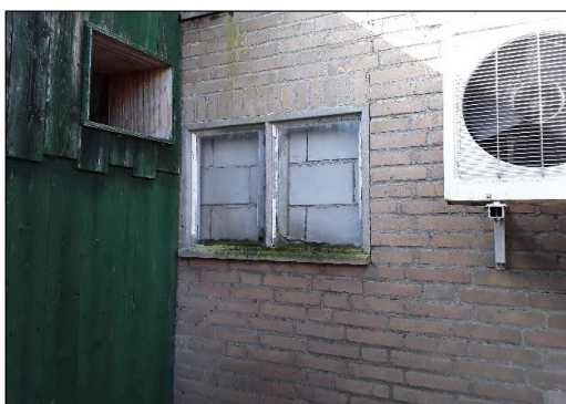
Beglazingskit (M06 en M07) Geen asbest aantoonbaar
