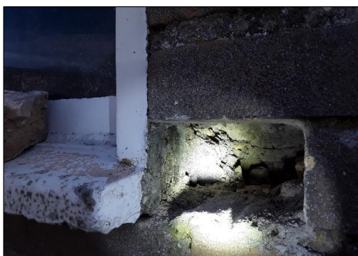
Kozijnen opslagruimte Geen asbestverdacht materiaal aangetroffen
