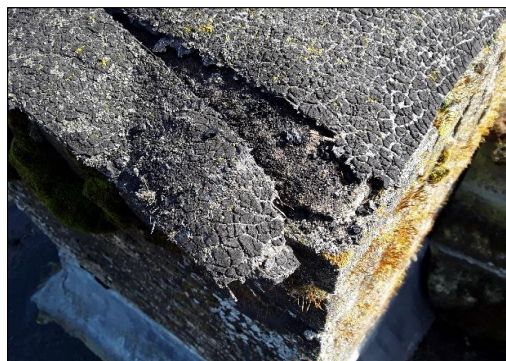
Detail bitumen schoorsteen Niet asbestverdacht
