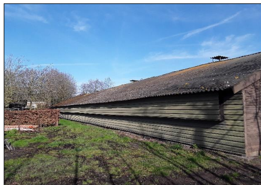
Buitenschil opstal 1 (dak) Asbesthoudend
