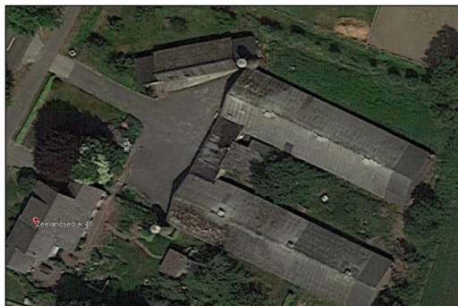
Bovenaanzicht opstallen Asbesthoudend
