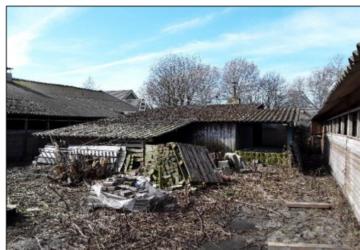
Dak opslagruimte Asbesthoudend
