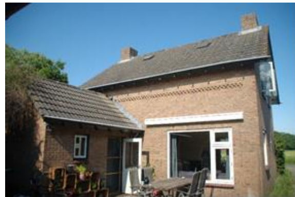
Achterzijde woning met bijbouw
