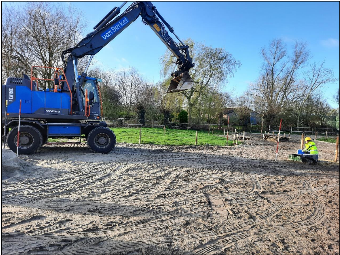
Figuur 2. Aanleg van werkput 1.
