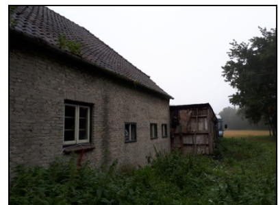
Figuur 5. Zuidoostzijde van het woonhuis.
