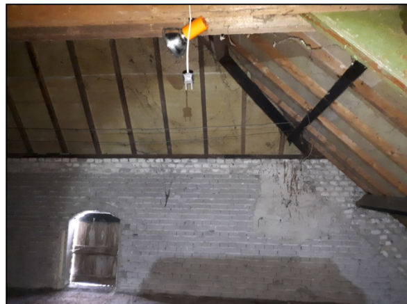
Figuur 14. Open zolder met toegang en vrije hangplekken zijn potentieel geschikt voor grootoorvleermuizen.
