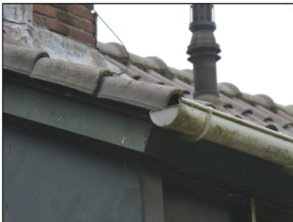
Figuur 9. Geschikte nestlocatie voor huismus onder het pannendak.
