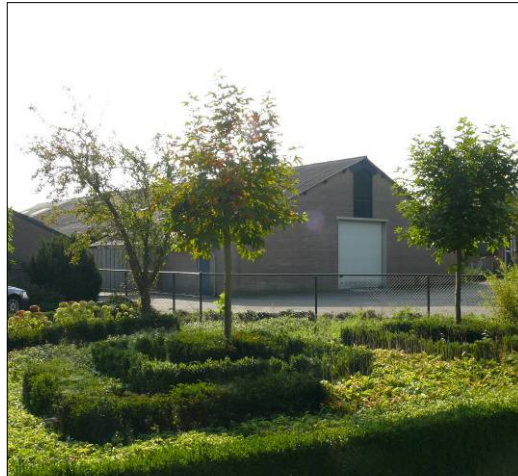
te slopen stallen varkenshouderij
