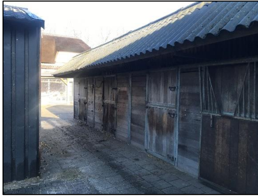
Foto 5. Bij-stal ten zuiden van de hoofdstal met houten muren
