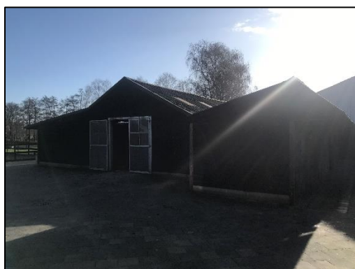
Foto 1. De te slopen paardenstal gezien vanuit het westen
