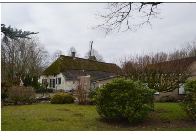
De beoogde bouwlocatie bekeken vanaf de achterzijde in westelijke richting met in het midden de boerderij met daarachter de molen en rechts de uitbouwen.
