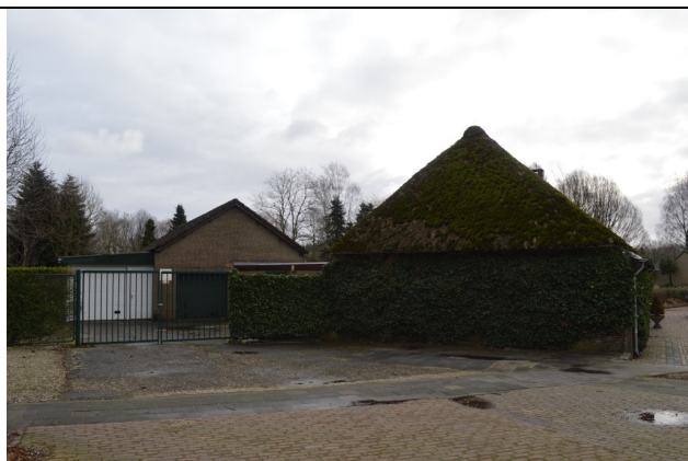
Aan de achterzijde is de boerderij uitgebouwd en verbonden met een bungalow en een aantal garageboxen. De hoogte van het dak van de bungalow is ongeveer 4,50 meter.
