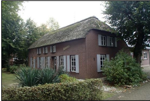
Overzicht woonhuis en siertuin.
