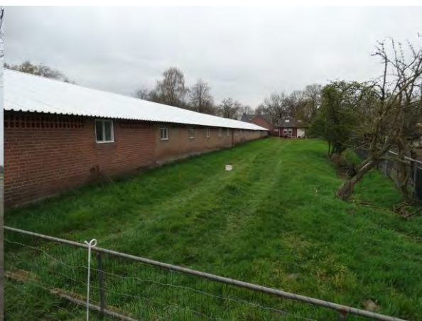
Figuur 10: Aanzicht achterzijde van de tweede te slopen varkensstal. Momenteel wordt het grasveld begraasd door schapen
