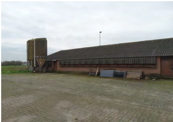
Figuur 3: Aanzicht van het eerste te slopen varkensstal en voedersilo's
