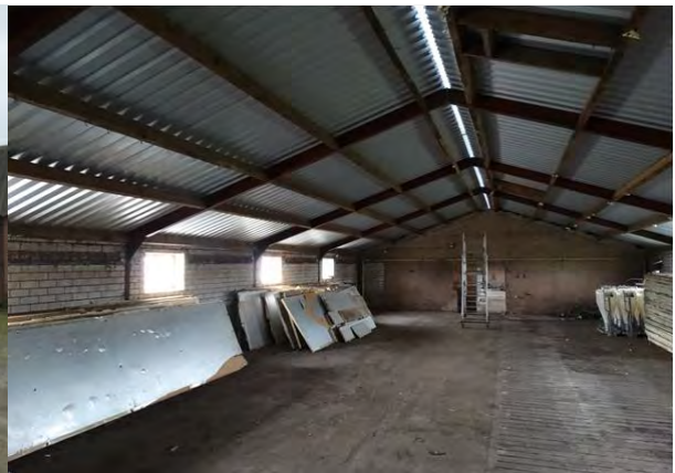
Figuur 4: Binnenzijde van de te slopen varkensstallen
