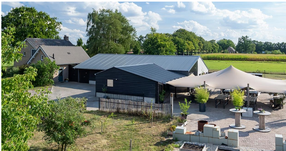
foto: daken schuren
