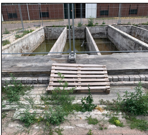
Foto 3: deelloccatie 3 voormalige bovengrondse tank
