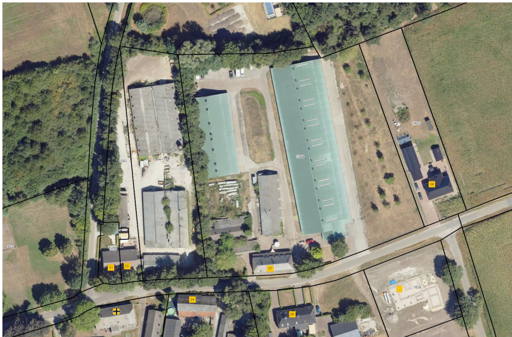
• Afbeelding 1: luchtfoto plangebied (bron: streetsmart.cyclomedia.com/streetsmart )
