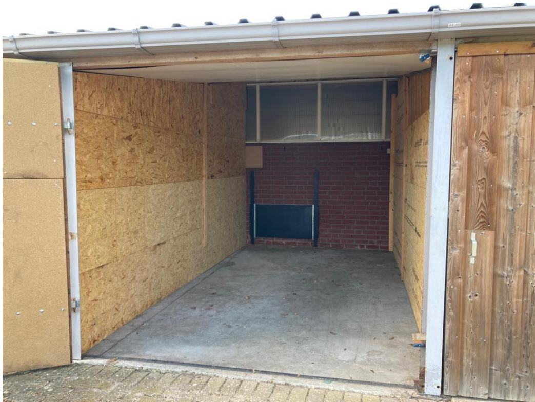
• Afbeelding 7: te slopen garagebox
