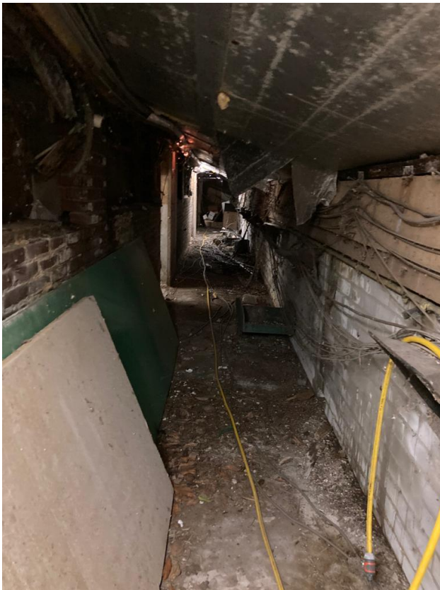
• Afbeelding 10: binnenzijde te slopen gebouw
