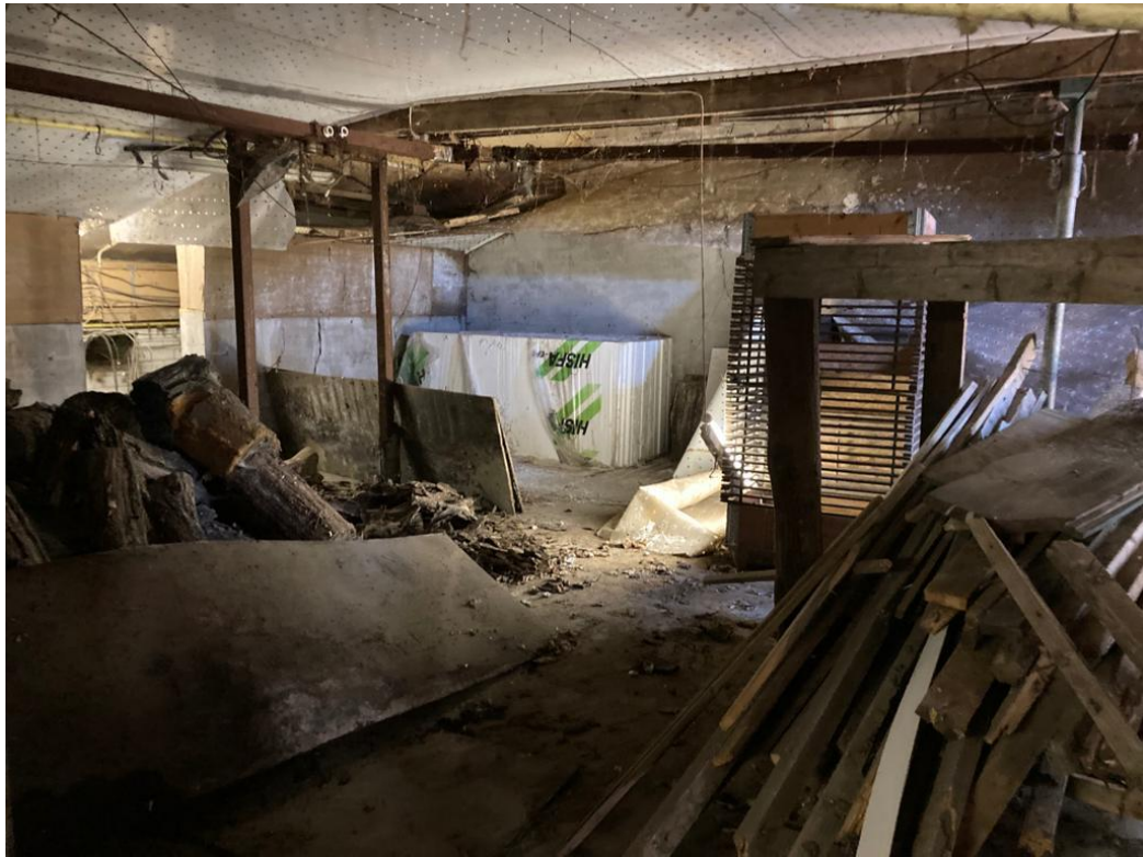
• Afbeelding 11: binnenzijde te slopen gebouw
