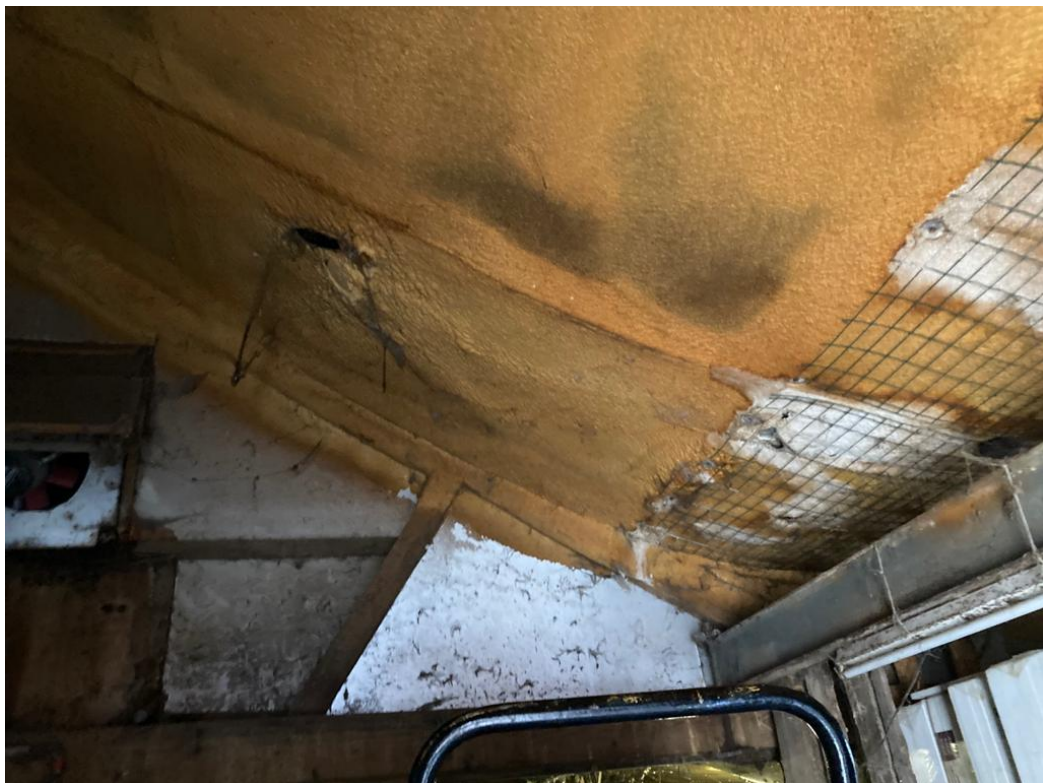
• Afbeelding 12: aanzicht te slopen gebouw
