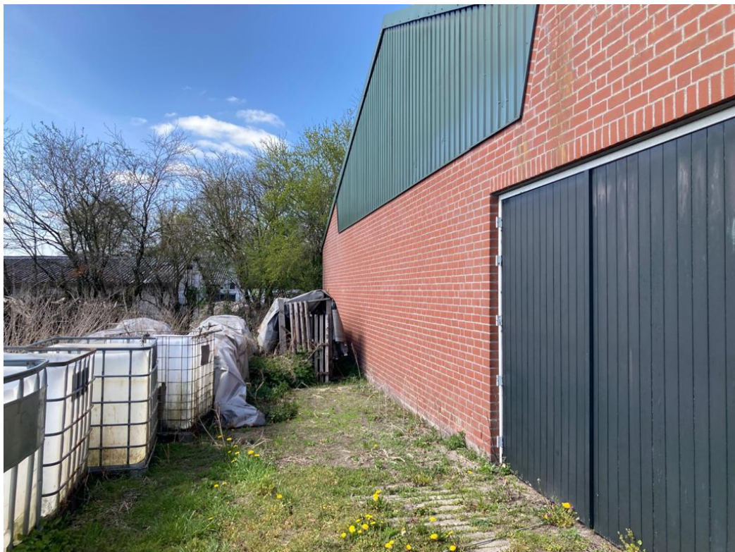
• Afbeelding 6: achterzijde te slopen gebouw met opslag diversen
