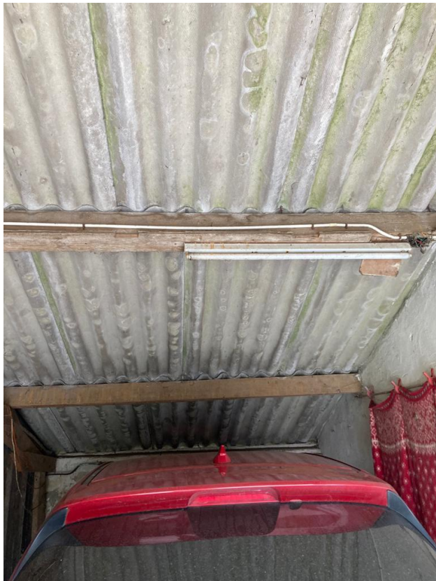
• Afbeelding 14: aanzicht te slopen garagebox
