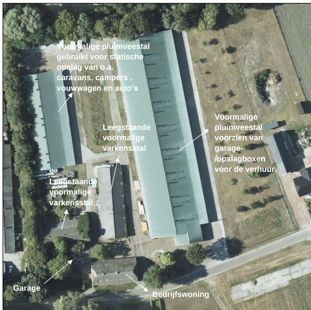
• Figuur 2.1: uitsnede luchtfoto ter plaatse van Loo 37 (bron: Cyclomedia)
