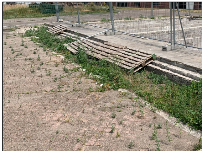
Foto 2: deelloccatie 2, onverharde deel naast gesloopte stal
