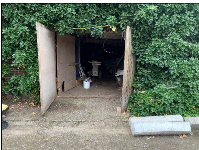
Foto 5: deelloccatie 4 opslag chemicaliën
