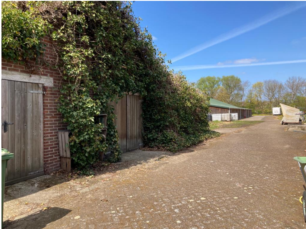
• Afbeelding 9: zicht op te slopen gebouw
