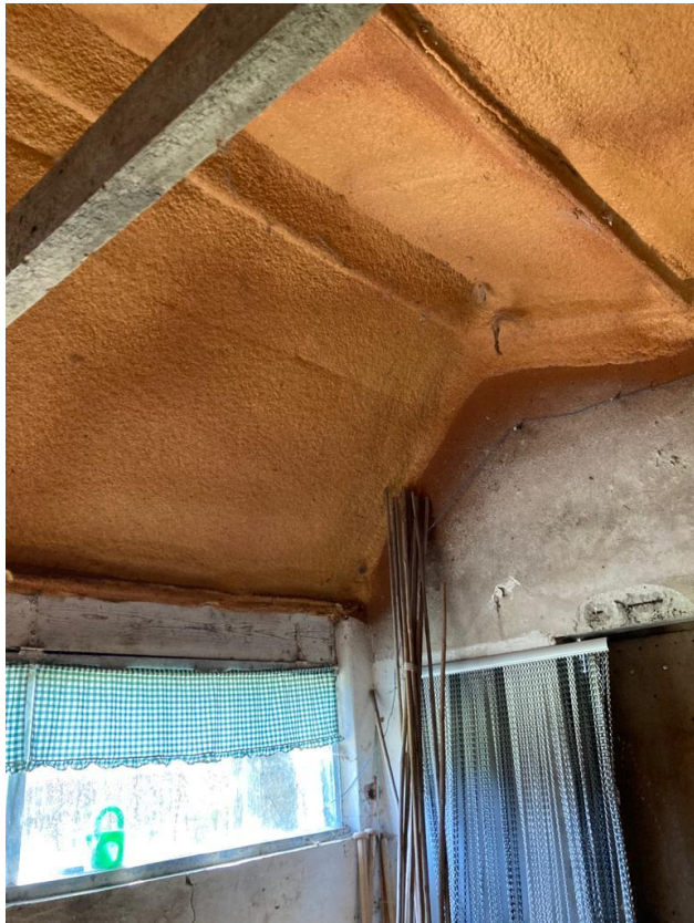
• Afbeelding 15: dakconstructie te slopen gebouw
