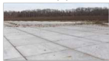
Foto 11: Verharding betonplaten.
