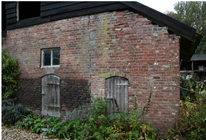
Detailopname van de rechterzijgevel
