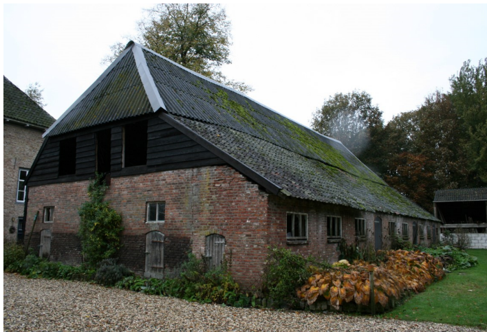
Blik op de zij- en achtergevel van de schuur.
