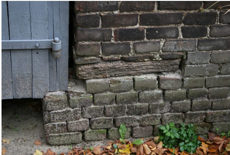
Detailopname van de gevel
