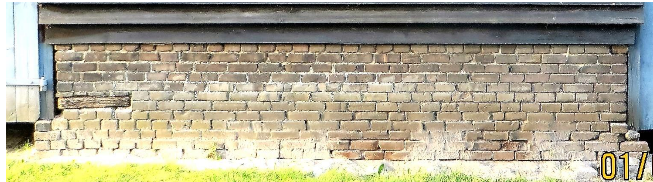
4, tussen dubbele staldeuren en enkele staldeur
