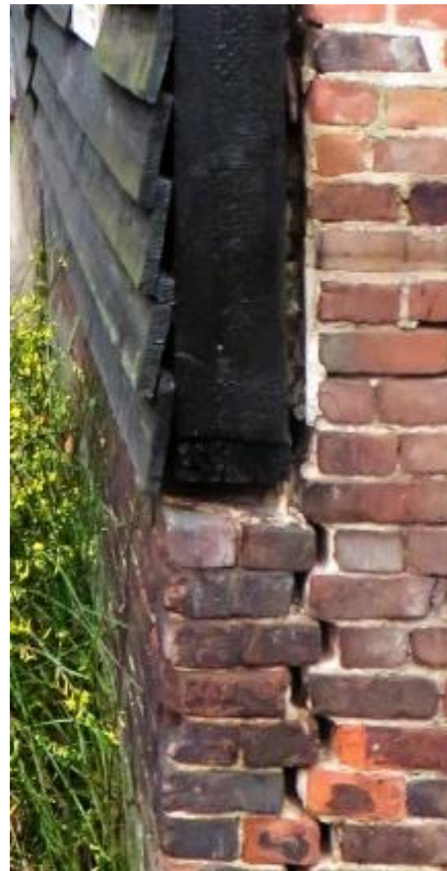
6, hoek zuid en oostgevel in 2016
