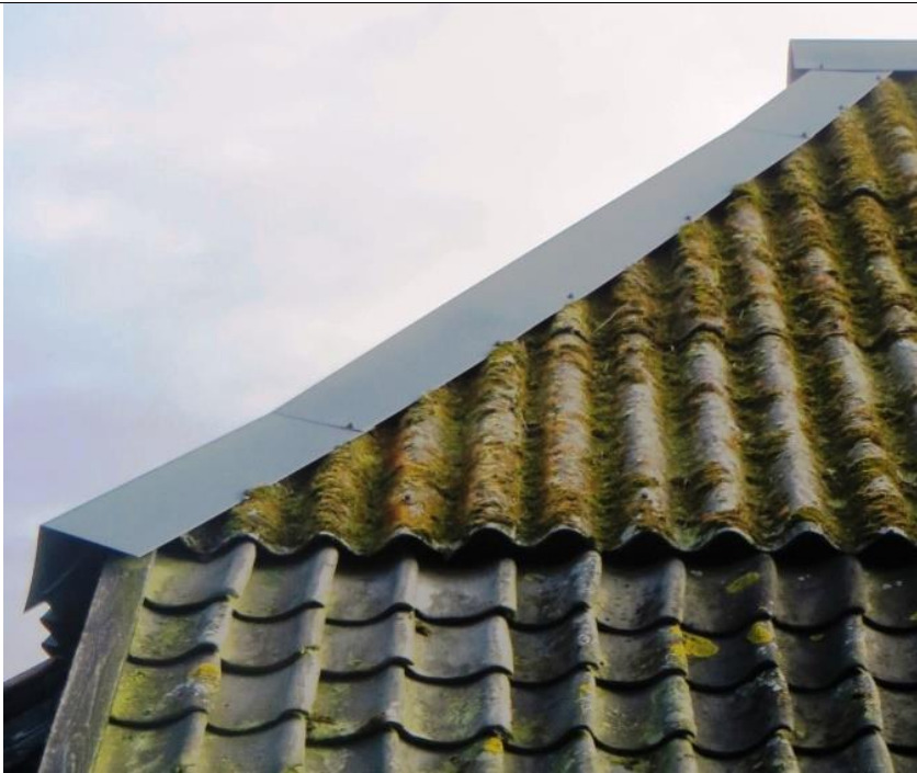
Westkant dak aanzicht vanaf zuidgevel Schuine hoekkeper overlapt 10 rijen pannen
