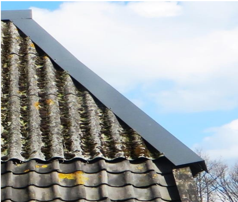
Westkant dak aanzicht vanaf zuidgevel Schuine hoekkeper overlapt 10 rijen pannen
