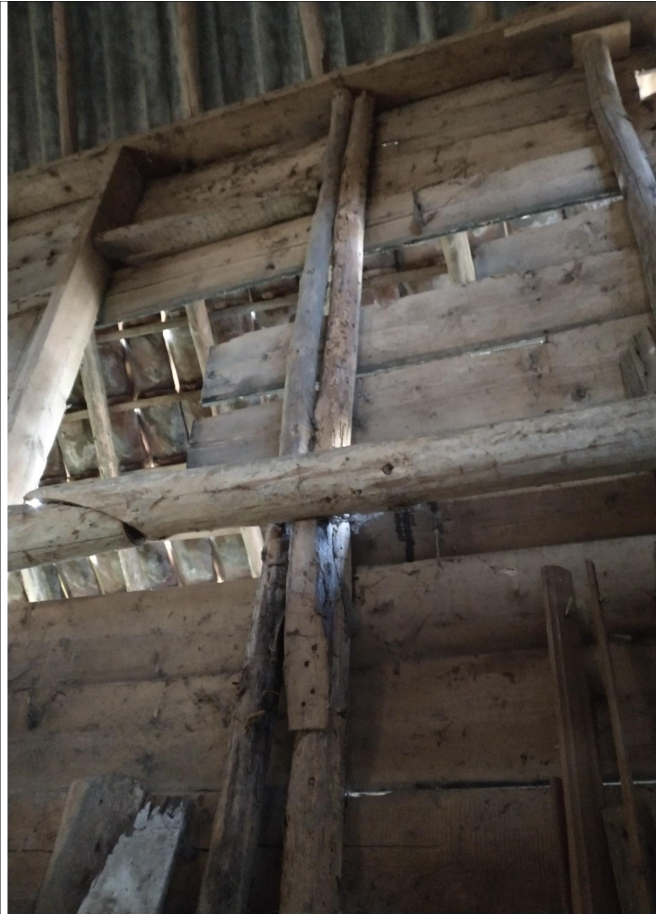
Vervangen dwars gebintplaat vervngaan door een nieuw gebint
