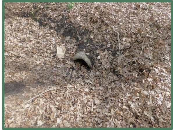
Betonnen duiker onder de Vinkelsestraat met wissel.
