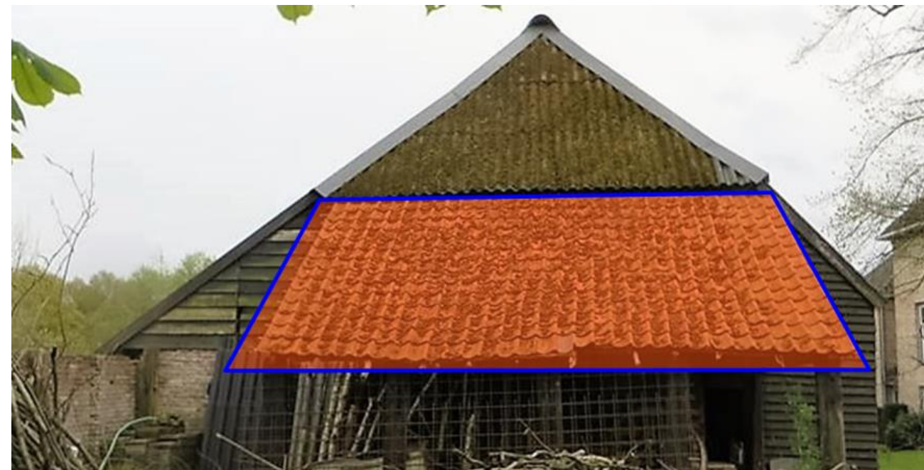
Dak no. 6 Hoekgedeelte is in het verleden ingestort en hersteld met restant, asbestgolfplaten, hoekkeper vlakken en rechthoekig dakvlak
