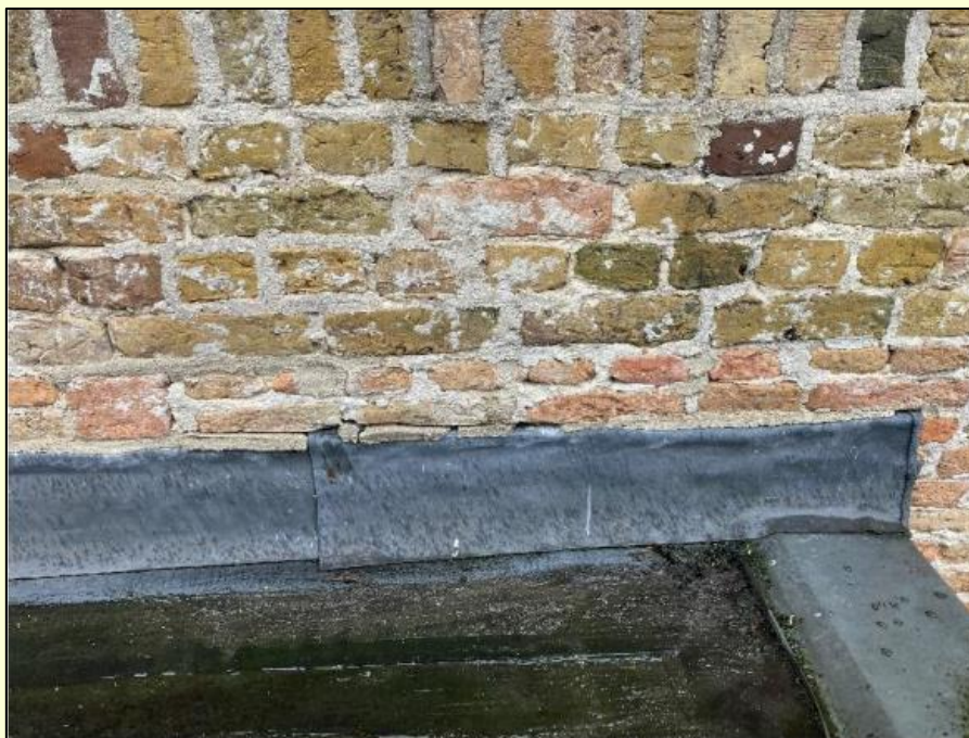
dak no. 8 / gevel no. 3: speciezoom los (foto 2020)
