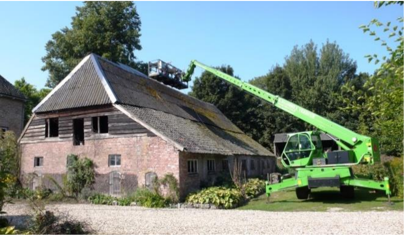
Dak nok, wind en waterdicht maken
