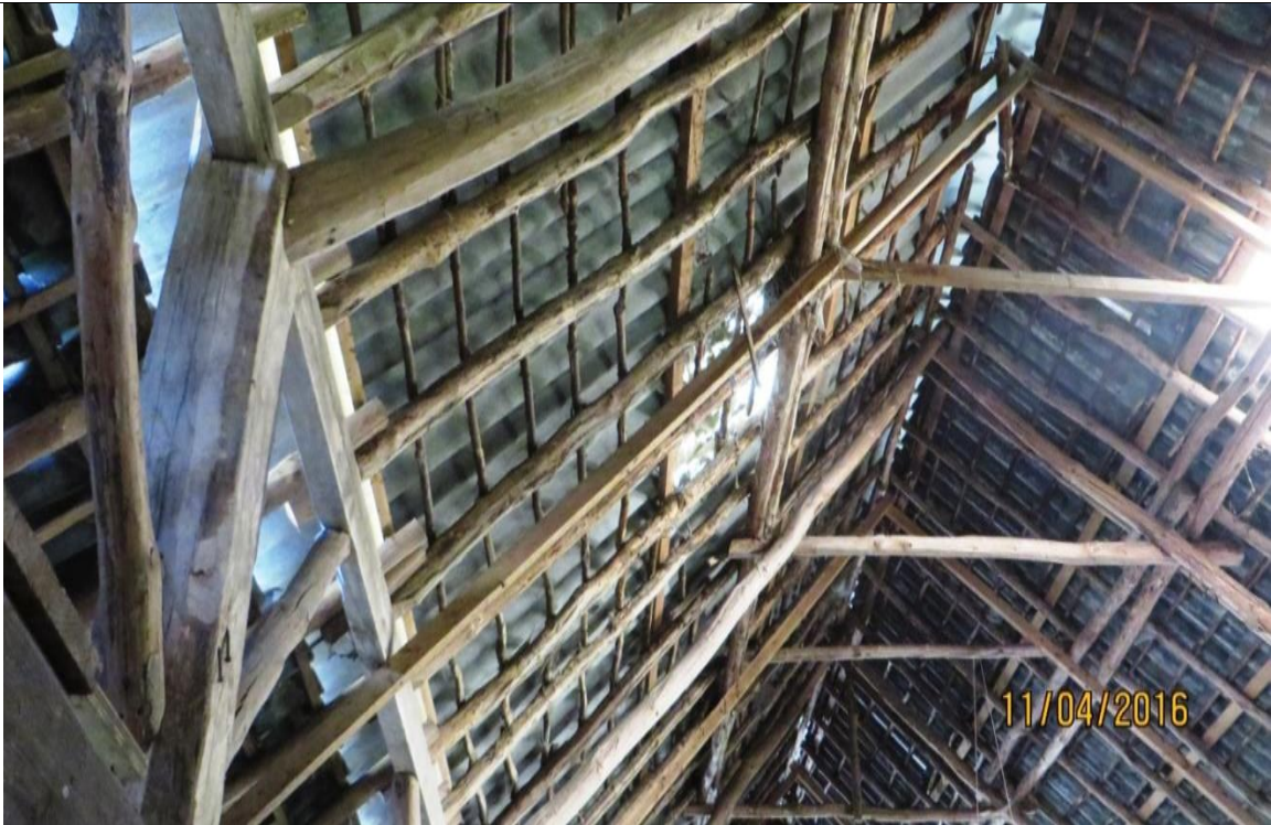
Spant op gebintstijlen, extra spant tussen twee stijlen in en dubbele enkele driedubbele gordingen
