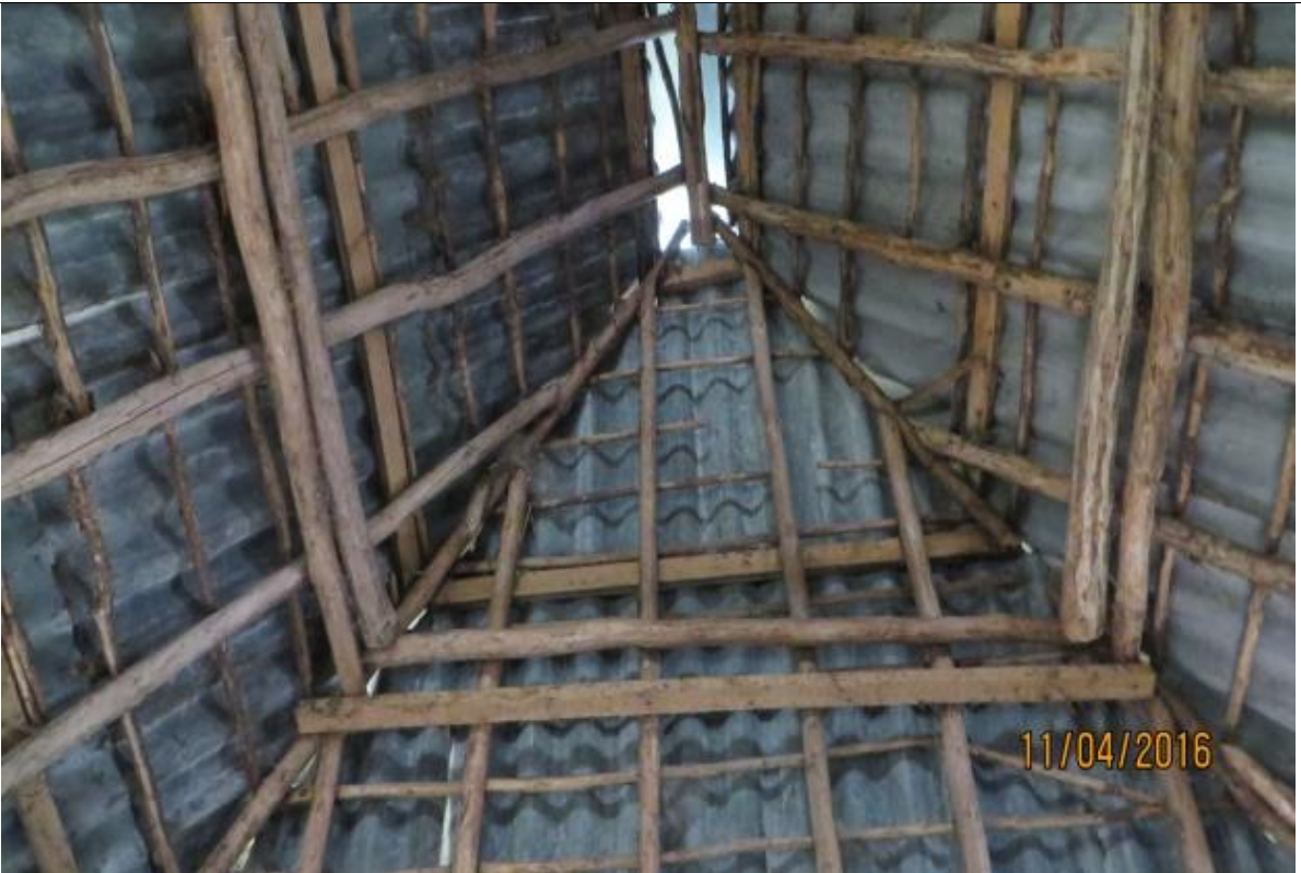
Noodreparatie aan de kapconstructie, extra ondersteunende constructies aangebracht
