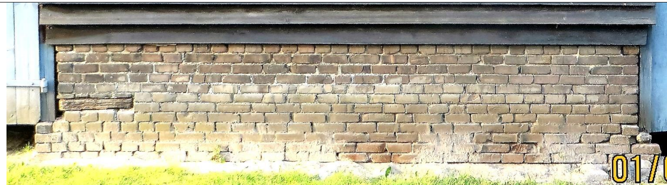
4, tussen dubbele staldeuren en enkele staldeur
