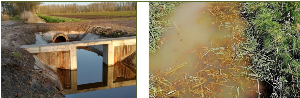
Aanleg nieuwe kantelstuw voorkomt afwatering van grondwater in de Vinkelse Loop.
