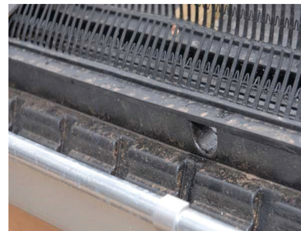
Figuur 19: De zogenaamde Vogelvide of vergelijkbare uitvoeringen geven wel mogelijkheid voor het maken van nesten, maar zorgt er voor dat er geen van buiten af door dieren bereikbare ruimten in gebouwen zijn (©Vogelbescherming Vlaanderen vzw).
