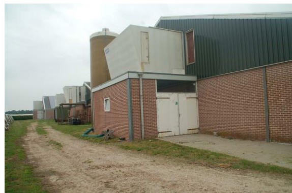
Achterkant stal 2, 6 en 7, met luchtwassers.
