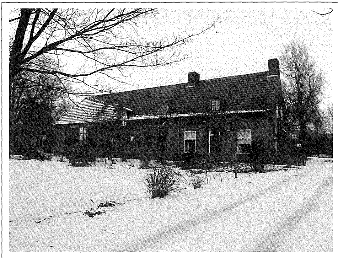
Foto 1. te slopen verbouwde boerderij op noordelijke deellocatie (Bosschebaan 32-34)
