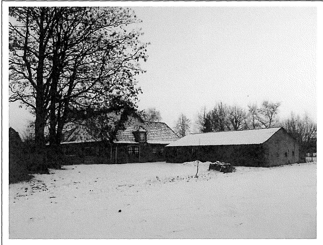
Foto 9. te slopen schuur op zuidelijke deellocatie met links 2 (oude) acaciabomen
