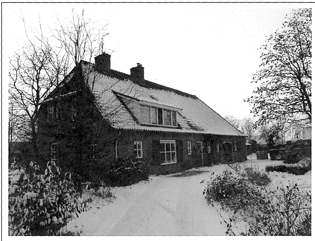
Foto 5. op te splitsen en intern te verbouwen woonboerderij op zuidelijke deellocatie (nr. 15)
