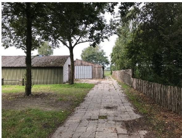
Bestaande inrit richting het achtergelegen agrarisch perceel. Deze zal heringericht worden en afgesloten met een poort.
