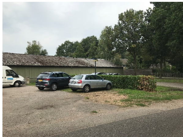
Bestaande parkeerplaats aan de Koffiestraat. Deze zal naar het achtererf verplaatst worden en aan de voorzijde zal een groene inrichting komen.
