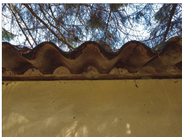
Figuur 17. Afgesloten ruimtes onder de dakbedekking
