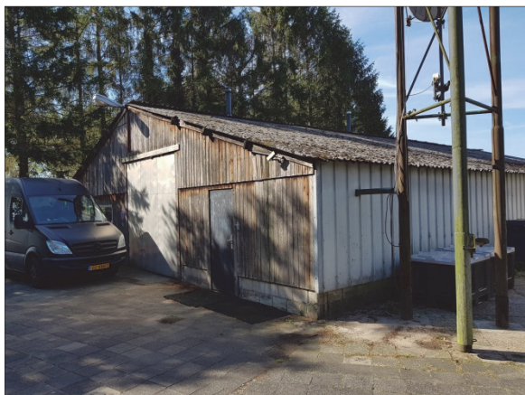
Figuur 5. Oostelijk bedrijfsgebouw binnen deelgebied 3
