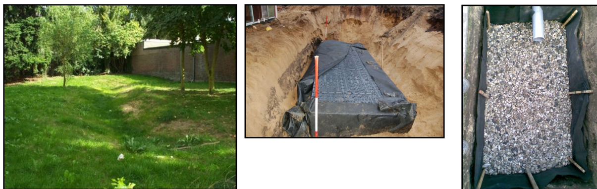
Figuur 22: Voorbeelden van infiltratiemogelijkheden
