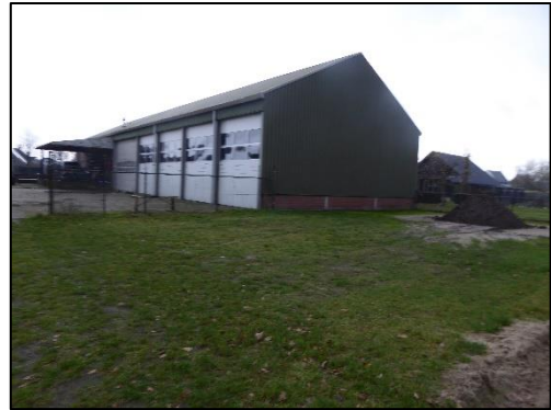
Achterzijde van de loods.
