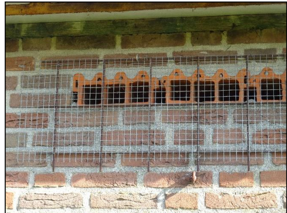
Figuur 16. Openingen aan de zijkant van de schuur die zijn afgedekt met gaas.
