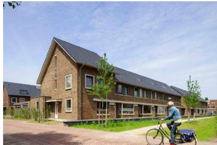
► Geveloriëntatie op openbare ruimte
