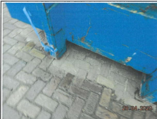
Foto 22. Inspectie rondom de container.
