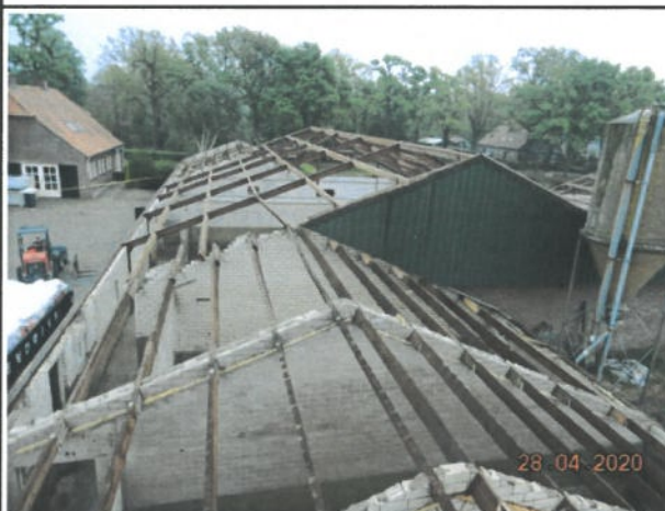
Foto 11. Verwijderde bron 2 van opstal 2.
