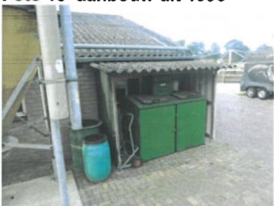
Foto 15 afdak bij opstal 2
