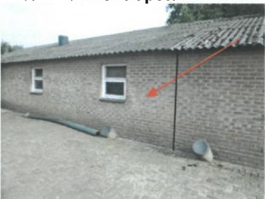
Foto 9 gedeelte van opstal 1 wat gesloopt gaat worden
