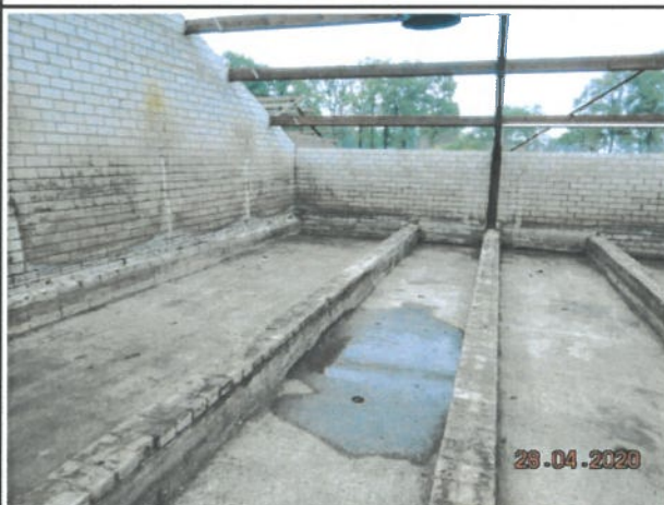
Foto 24. Inspectie open mestputten in opstal 2.
