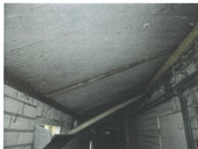
Foto 2 binnenkant dak opstal 1
