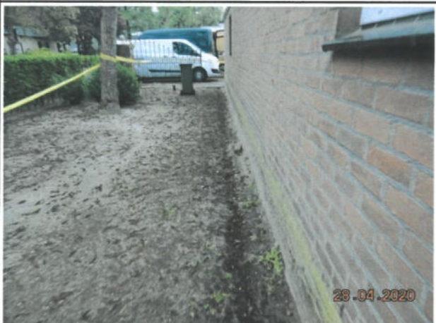
Foto 27. Inspectie gevel van opstal 1.
