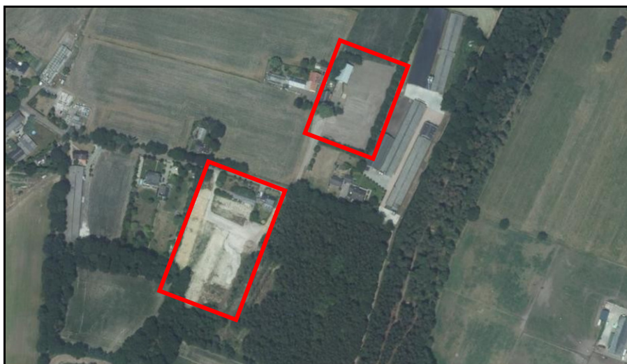
Figuur 2 Luchtfoto planlocatie, stallen zijn reeds gesloopt.
