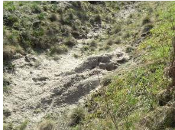
Foto 7: Vluchtpijp (V2) aan verkeerde zijde dassenraster A50
