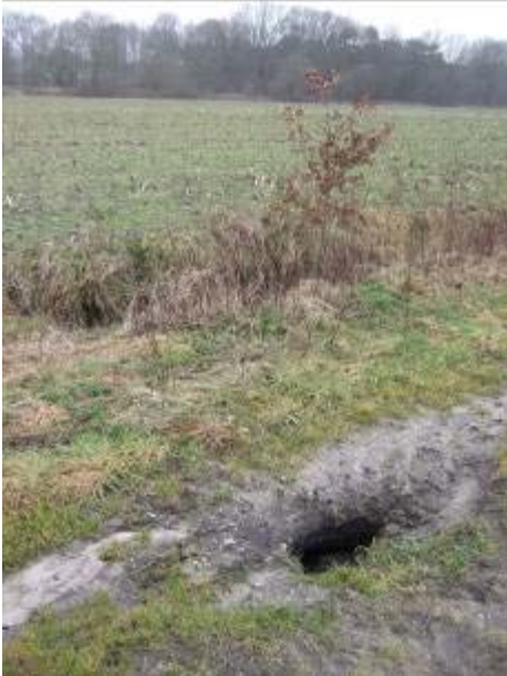
Foto 4: Ingestorte gang/kamer van burcht 2 onder zandpad
