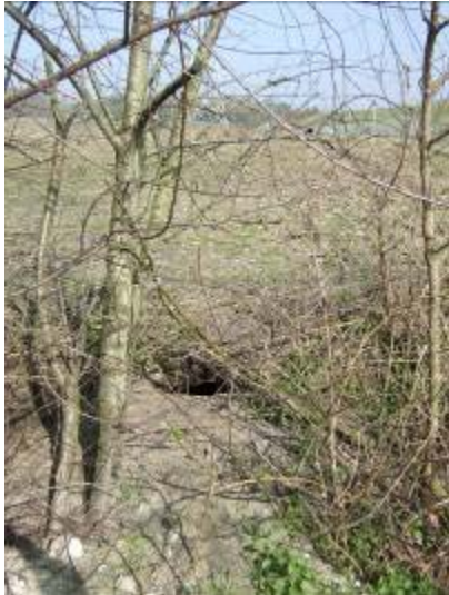
Foto 6: Vluchtpijp (V1) in houtwal nabij dassentunnel B
