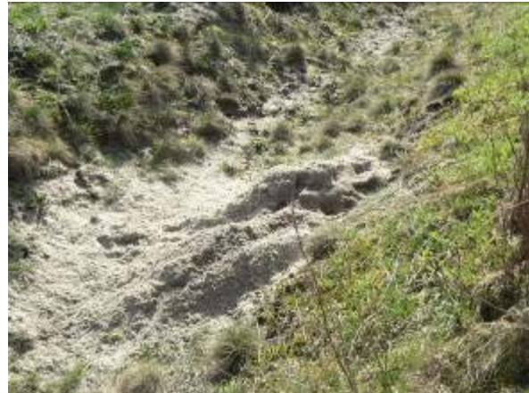
Foto 7: Vluchtpijp (V2) aan verkeerde zijde dassenraster A50
