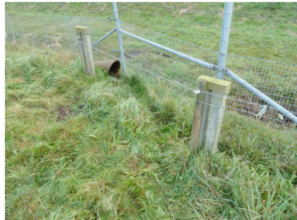
belopen dassentunnel ten noorden van perceel 12
