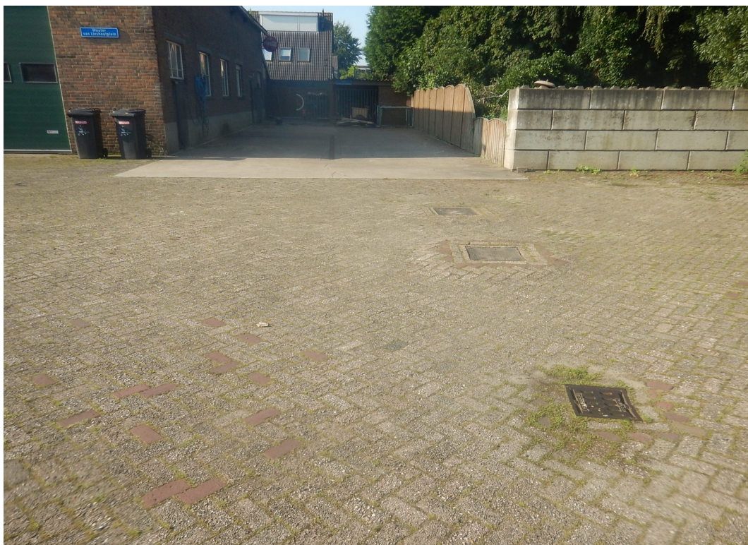
Figuur 13: Goot en putdeksels in het zuidoosten van het plangebied.
