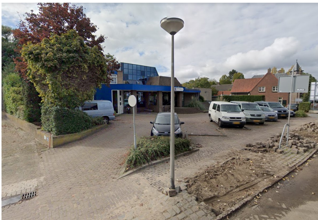
Figuur 15: Noordelijke deel van het plangebied, Hoofdstraat 47a-49 (Google Maps Street View, oktober 2020).
