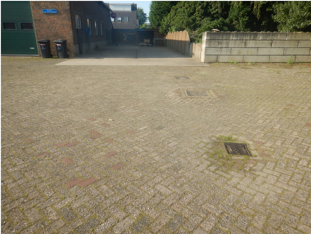
Figuur 44: Putdeksels tussen boorpunten 4 en 7. Foto genomen tijdens het veldwerk.
