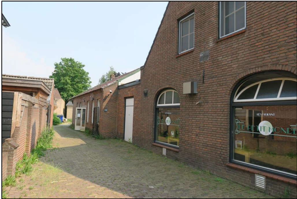
Figuur 3 Gebouw C van de planlocatie.
