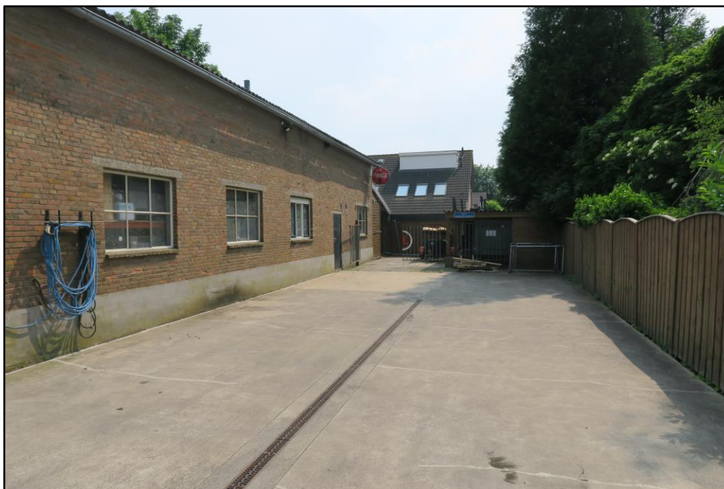
Figuur 2 Verharding op de planlocatie. Links op de foto is gebouw B te zien.
