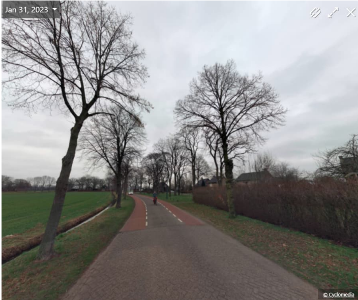
Figuur 9 Bestaand wegprofiel Nobisweg, overgang asphaltverharding/klinkerverharding (bron: Cyclomedia, 2023)
