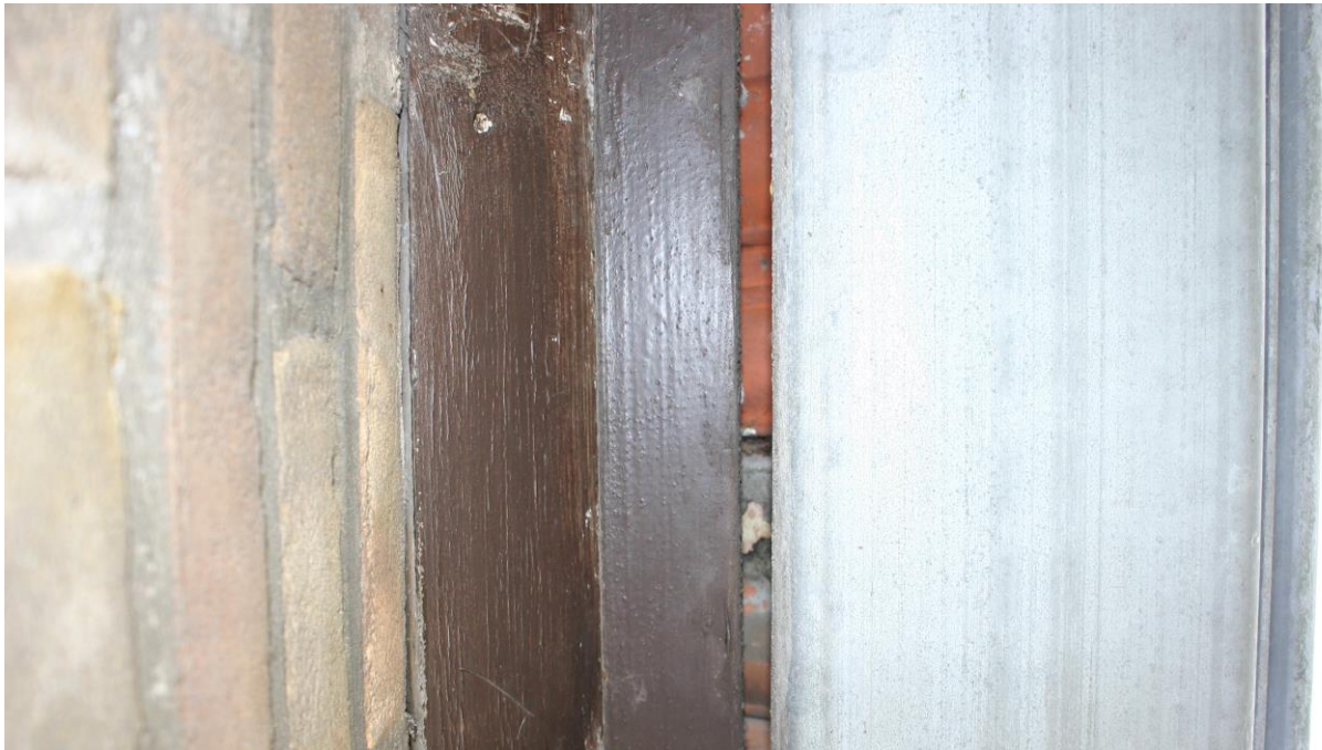
Figuur 4.5.4. Onderaanzicht van de buitenmuur, houten betimmering, dakpannen en dakgoot (v.l.n.r.). Vleermuizen kunnen de spouw niet in door de gladde lat.
