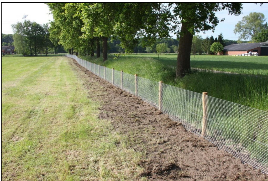
Voorbeeld van een recent aangelegd dassenraster (bron: HBA totaal).
