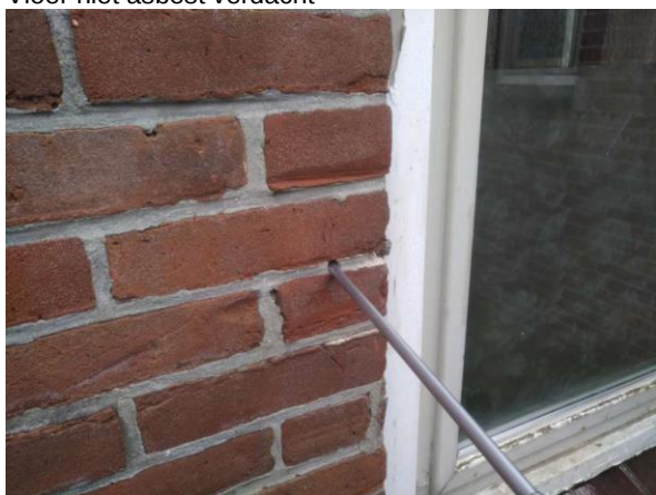
Spouw geen asbest
