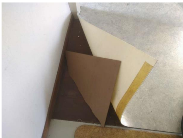
Vloer niet asbest verdacht
