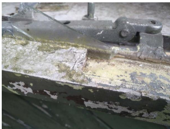
Schuur stopverf geen asbest
